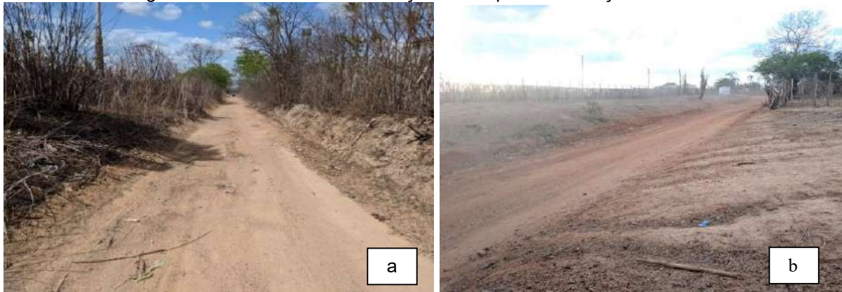
Figura 7 – Estrada IBI-01 na estação seca após manutenção de rotina
