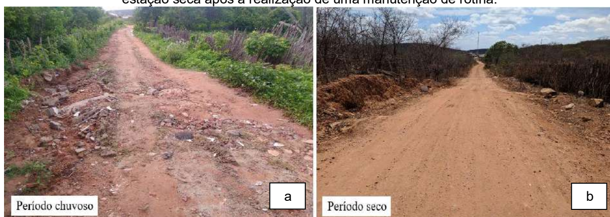
Figura 6 – Estrada IBI-01 em distintos períodos: (a) na estação chuvosa sem manutenção e (b) na estação seca após a realização de uma manutenção de rotina.
