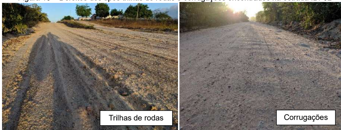
Figura 10 – Defeitos dos tipos trilhas de rodas e corrugações encontrados na estrada IBI-02
